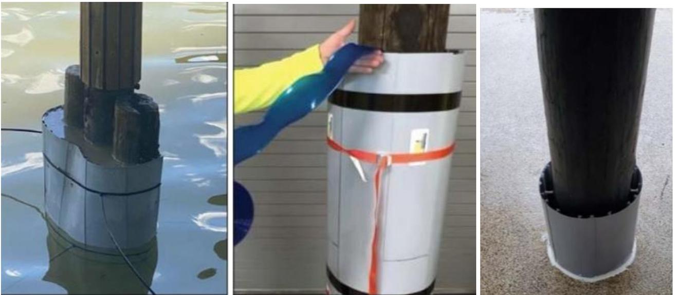
图三: Form-A-Tube®可用于创建任何形状的新桩。槽钉在使用三管法放置灌浆之前安装。T型槽将管道与灌浆粘合在一起。
