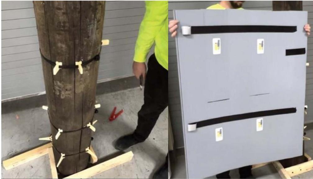
图二:应该在桩周围安装间隙和裙板销。在处理和安装过程中,可以使用胶带来防止条带滑动。
